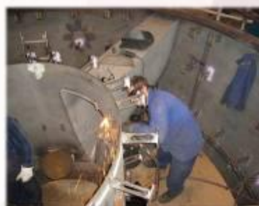
Bravarsko-cjevarsko-zavarivački radovi Locksmithing - Piping - Welding
